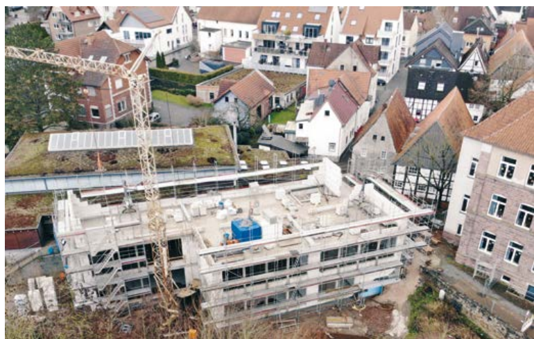
Blomberg. Der Baufortschritt des Erweiterungsbaus der Grundschule am Weinberg ist deutlich zu erkennen.
