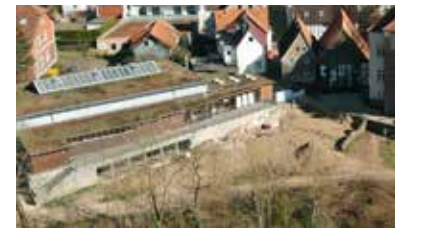
Blomberg. Das Baufeld für den Neubaustrakt ist hergerichtet.
