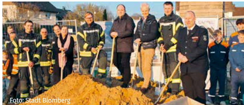
Cappel. Freuen sich, dass die Bauarbeiten beginnen (mit Schaufel v. l.): Christopher Schramm (stellv. Löschgruppenführer Cappel), Juliane Mauermann (Projektleitung Eigenbetrieb Blomberger Immobilien und Grundstücksverwaltung), Martin Brächtker (Löschgruppenführer Cappel), Bürgermeister Christoph Dolle, Architekt Stefan Brand, Cord Finke (stellv. Wehrführer), Joachim Hartfelder (Wehrführer).
